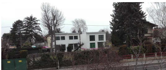
Glangasse 35A (Ansicht Thayagasse)
